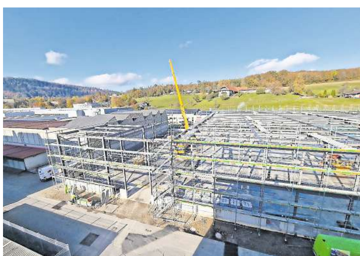
Stahl bildet das Gerüst der neuen Halle.
