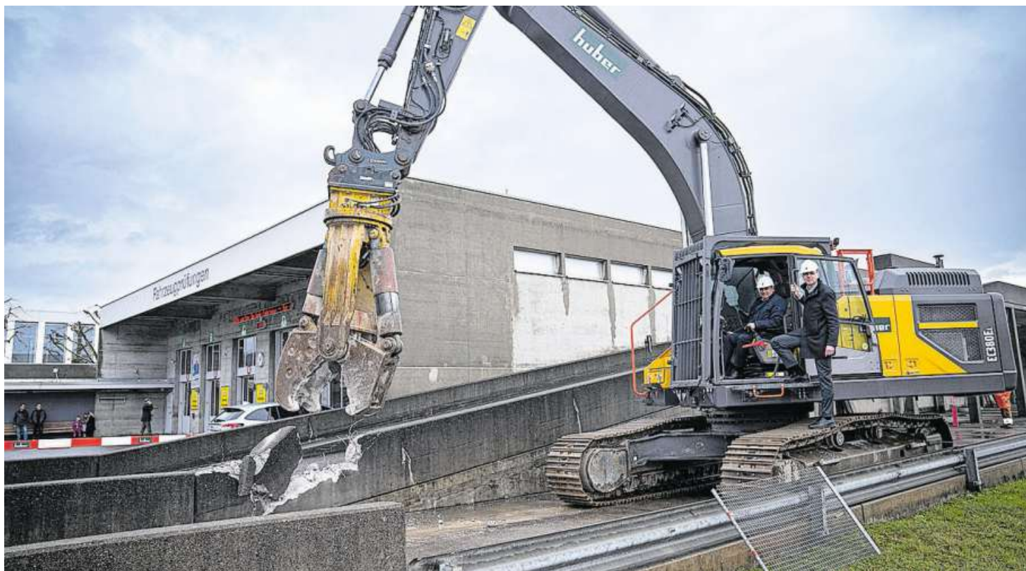
Die Regierungsräte Dieter Egli und Markus Dieth schaffen Platz für die Vergrösserung der Prüfhalle.
