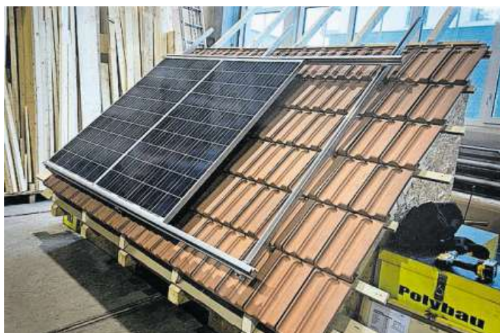
So sollte das Übungsdach nach Abschluss der Aufgabe aussehen.
